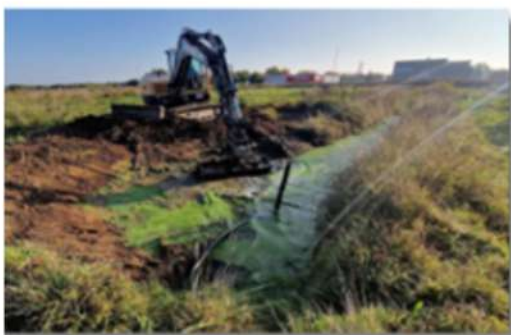
Chantier avec prestataire paysagiste (Pelle 8T godet inclinable)
