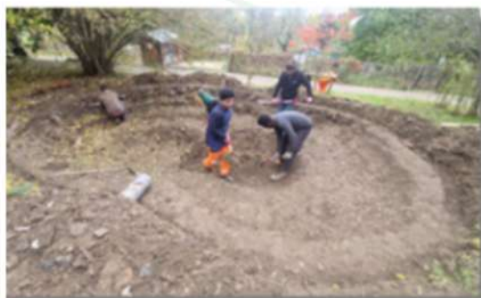
Chantier avec association de réinsertion pro, et service technique communal
