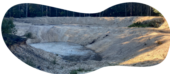
Hourtin - restauration de la mare n°1
